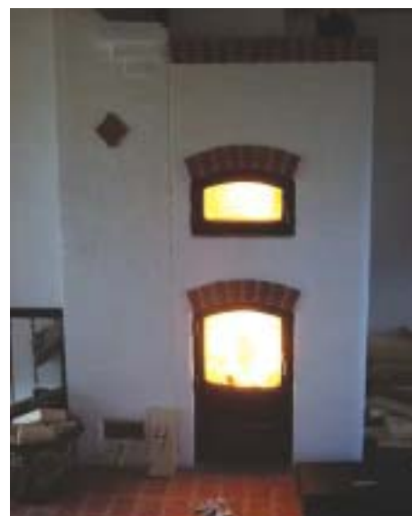
Der er nu fuld gang i ovnen. Gasserne brænder i bageovnen/sekundær forbrænding.
